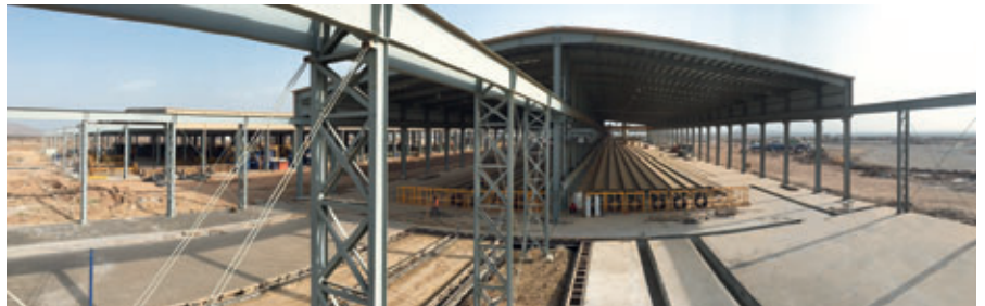
Vista aerea del sito no. 1 dei 6 previsti nel nuovo impianto di Jazan, destinato alla produzione di solai precompressi con macchine Evo Nordimpianti
