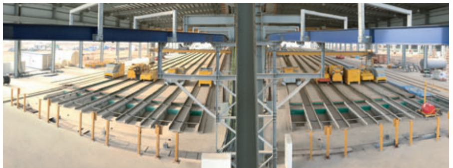
Vista delle due campate ognuna predisposta con 8 piste di produzione da 165 metri di lunghezza presso lo stabilimento di Jizan.
