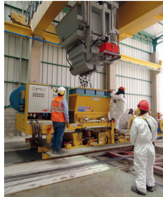
Démarrage de la production : la benne à béton fournie par la société Marcantonini décharge le premier lot de béton dans la fileuse, ici pour la fabrication de poutres en T.
