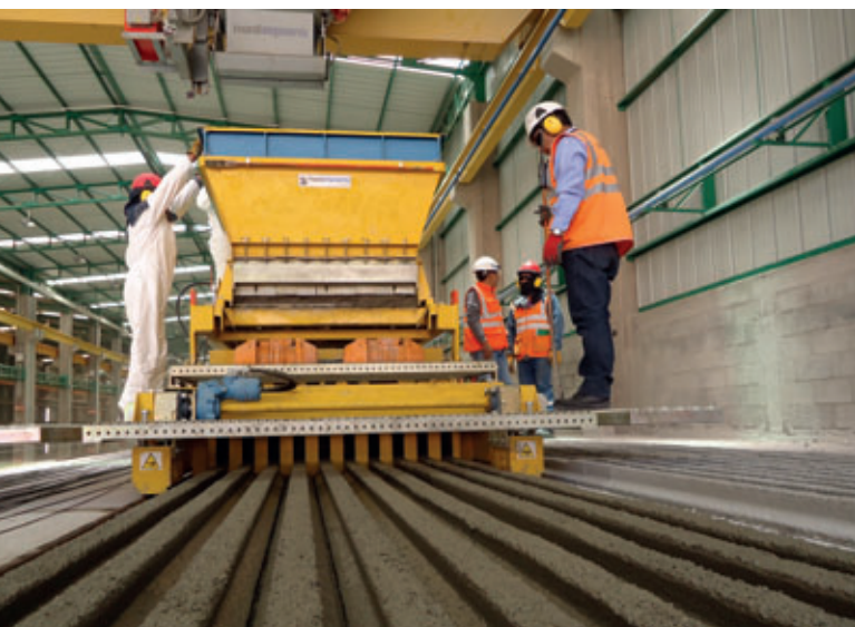
La fileuse universelle pour poutres en T pendant le bétonnage. La qualité du produit terminé est bien visible.
