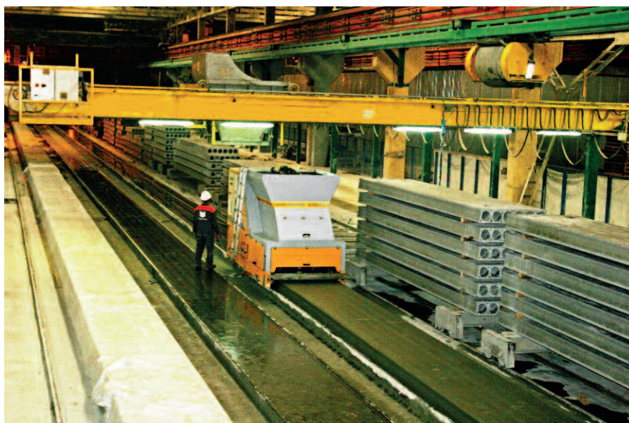
ООО «Завод ЖБИ 5» провел модернизацию существующего производства, смонтировав линию по выпуску пустотных плит шириной 1200 мм
