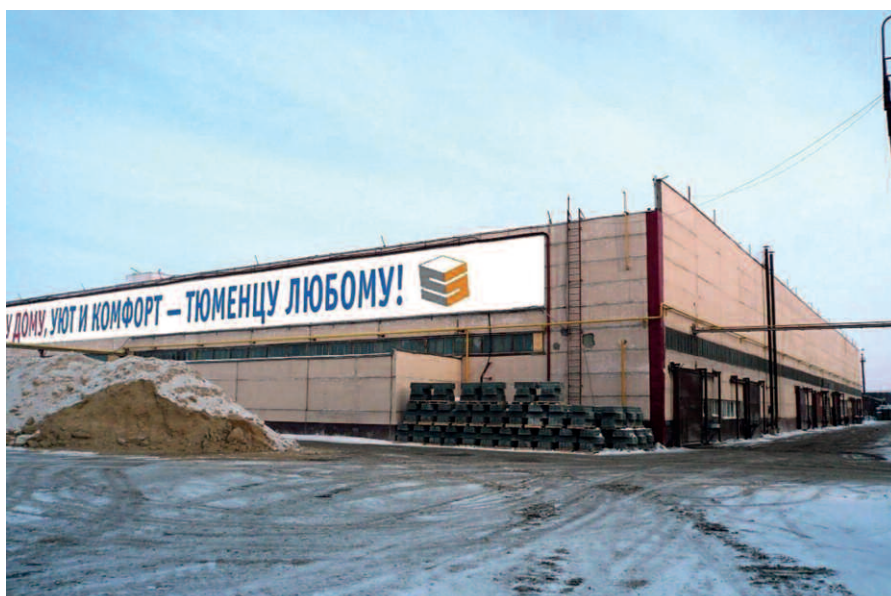
Тюменское ООО «Завод ЖБИ 5» стало первым российским партнером и постоянным заказчиком компании Nordimpianti
