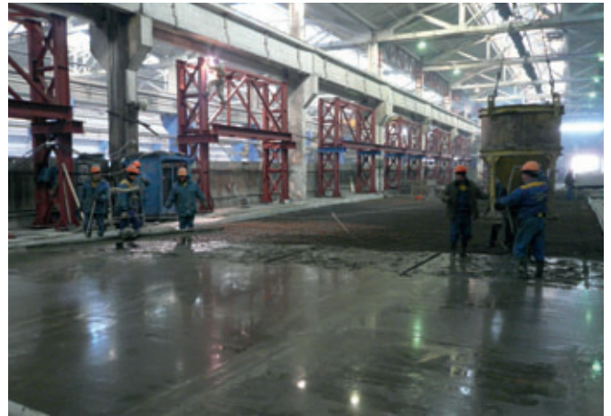
Construcción de la planta
