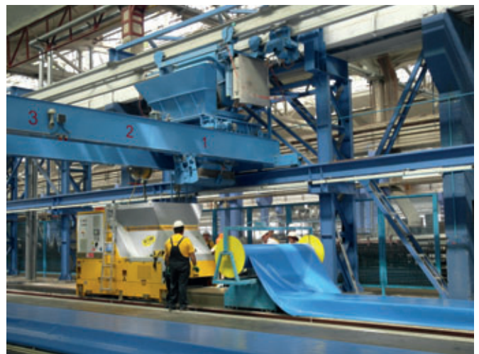
Suministro de hormigón completamente automático: cuba aérea en funcionamiento
