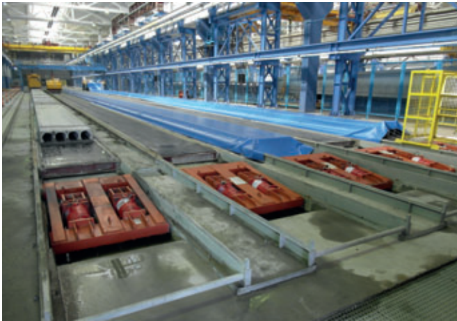
Vista general de la nueva línea de producción de placas alveolares pretensadas
