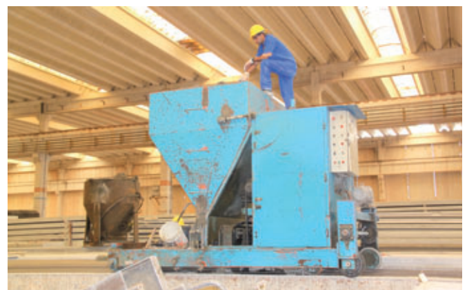
Vecchio estrusore in fase di getto
