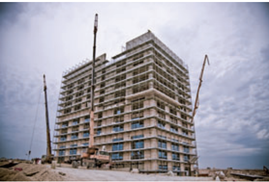
Le projet Smart City Malta avant achèvement des travaux
