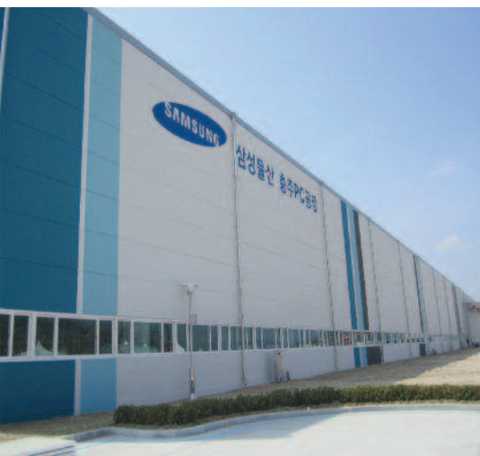
Fachada externa construída de painéis de parede alveolares
