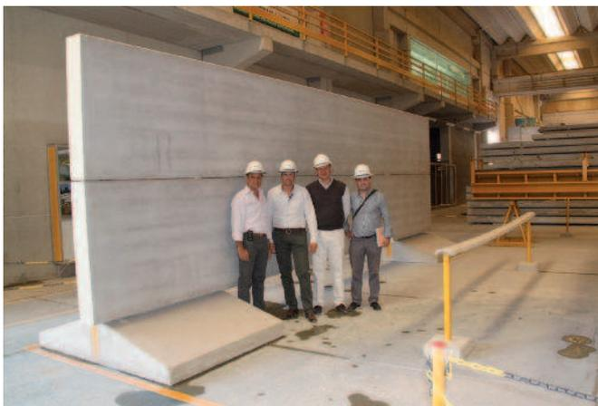
Foto 2: Um exemplo de aplicação das lajes alveolares para paredes
