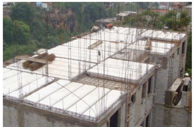
*Les dalles de plancher sont généralement constituées de poutres en T précontraintes et d'argile de remplissage*
