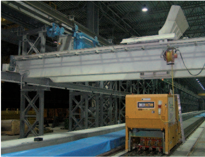
A fábrica abrange 5 galpões com 150 m de comprimento e uma central de concreto fornecida pela companhia italiana Simem
