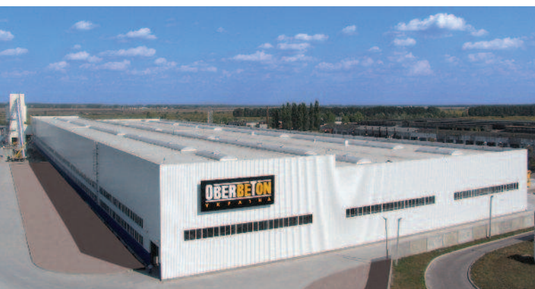
Nordimpianti aumentou sua credibilidade no mercado internacional com o fornecimento de uma linha de produção completa para a Oberbeton Ukraine
