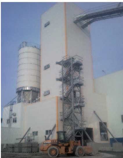
A usina vertical de concreto é uma Simem BetonTower T88 com um sistema de carregamento de agregados do chão através de uma tremonha subterrânea de recebimento de agregados com capacidade para 25 m 3 e uma correia transportadora de 94 m, inclinada a 20°
