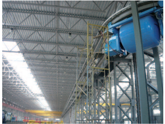
Um sistema de trilhos totalmente automático, equipado com caçambas aéreas de 2 m 3 e uma ponte rolante de 24 m de largura para facilitar a distribuição do concreto. No total, o sistema de distribuição cobre mais de 800 m lineares da área de produção
