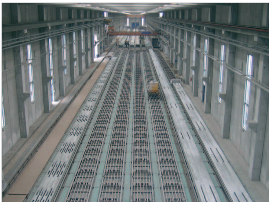
La halle de 350 m de long est divisée en zone de fabrication (au premier plan, sur la photo) et en zone de séchage (arrière-plan)
