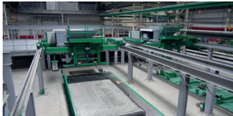
Distribuidor de hormigón con estación de compactación
