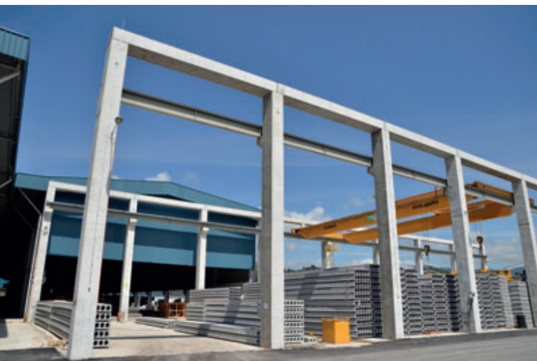
Zona de almacenaje para placas alveolares pretensadas
