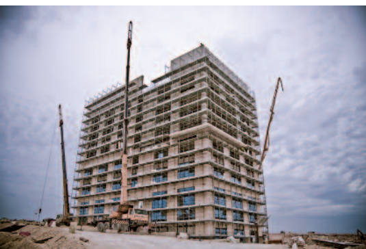
Finalização da Fase 1 do projeto Smart City Malta
